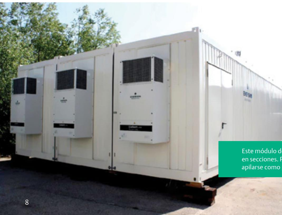
Este módulo de centro de energía fue prefabricado en secciones. Puede expandirse a nivel del suelo o apilarse como pisos múltiples.
