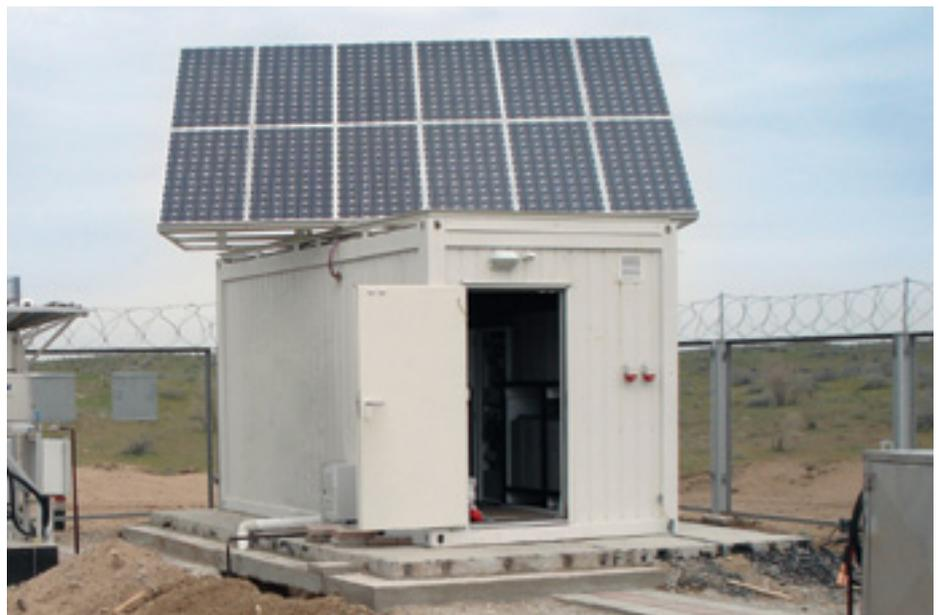
*Figura 2. Unidad remota con energía híbrida*
